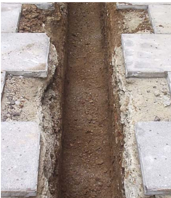
Foto 2. Tram de la rasa ja rebaixada totalment.
